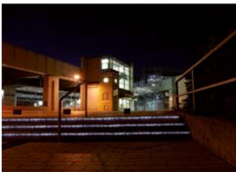
Kennzeichnung von Gefahrenpunkten z. B. Treppenstufen
