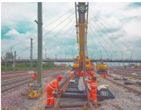
Präzision in allen Teilbereichen des Gleisbaus
