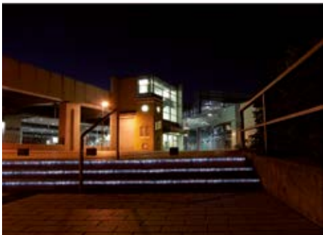
Kennzeichnung von Gefahrenpunkten z. B. Treppenstufen
