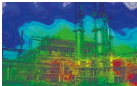
Akustisches Foto eines Industriekomplexes aus einer Entfernung von 300 Metern.
