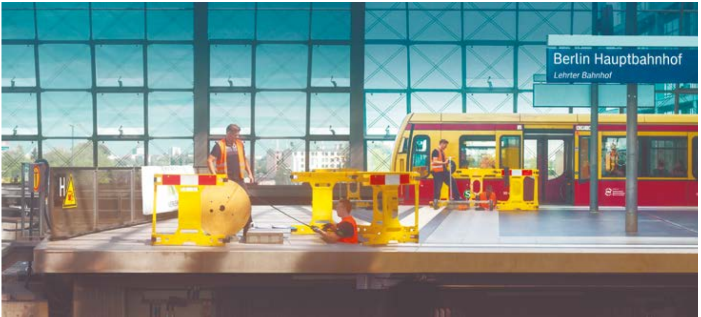
Bahnhöfe und Gleisanlagen statuen wir mit modernster Technik aus
