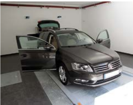
Übergabekabine des automatischen Park-systems Augustenkarre in München mit 19 Stellplätzen (LPh 1–8)
