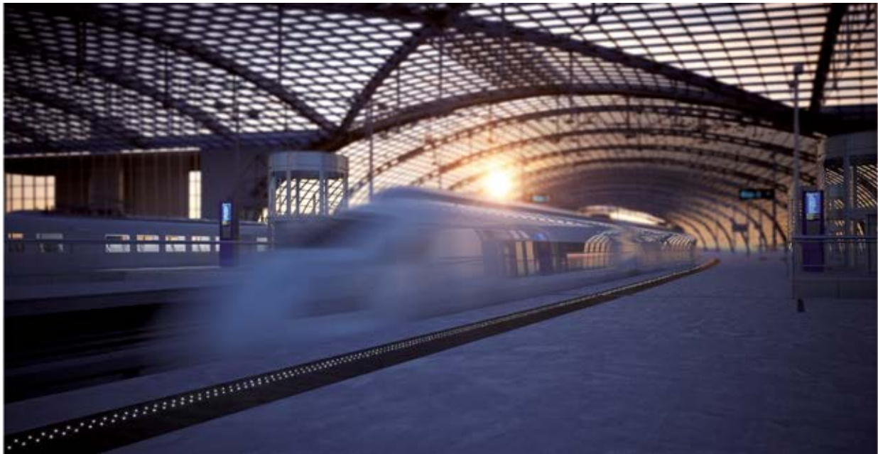
Sicherheitskennzeichnungen am Bahnsteig
